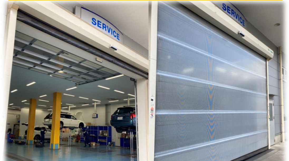
工場出入り口に自動開閉式シートシャッターを導入
