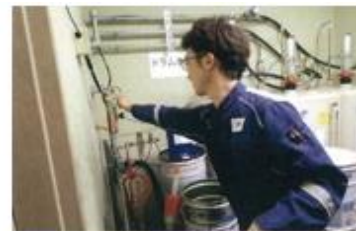
③圧送式ポンプの圧力遮断
