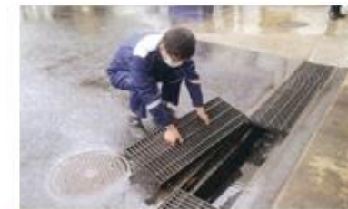
④-1 排水溝からの流出防止
