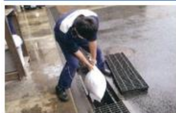
④-2 排水溝からの流出防止
