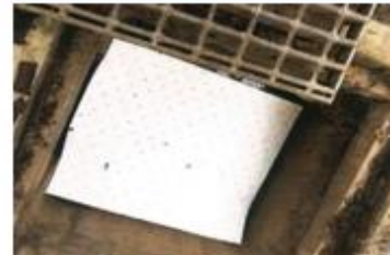
④-5 排水溝からの流出防止
