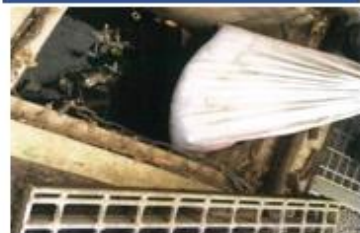
④-3 排水溝からの流出防止
