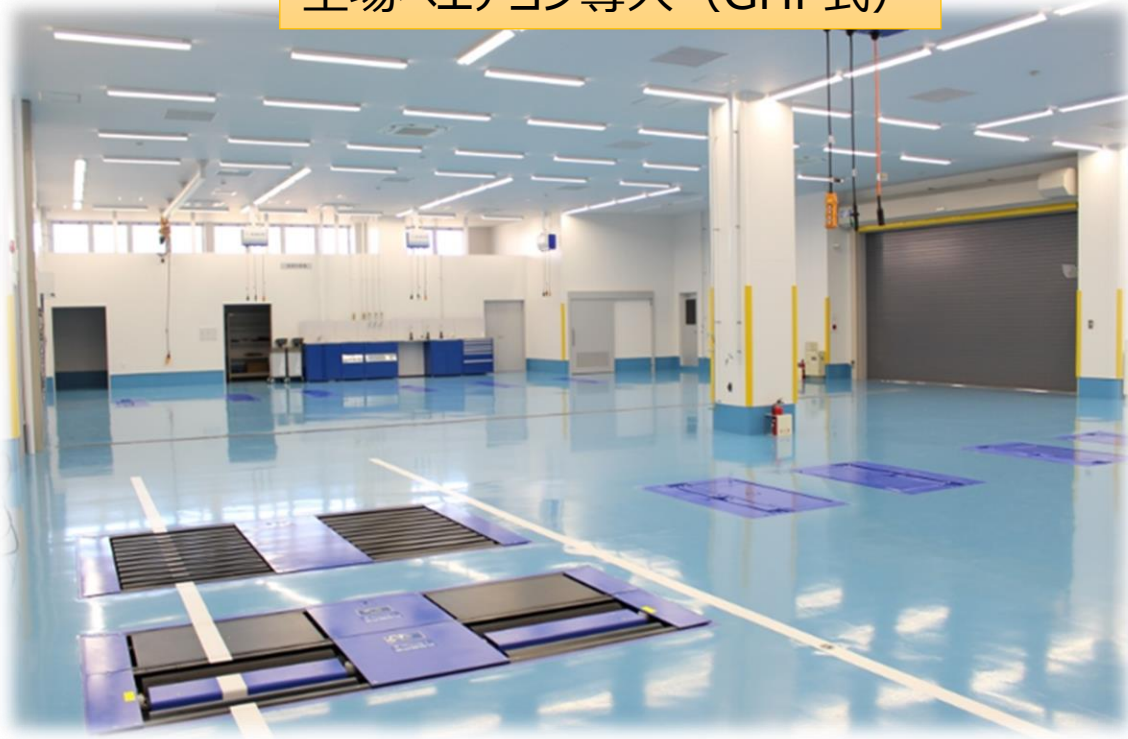
工場へエアコン導入（GHP式）
