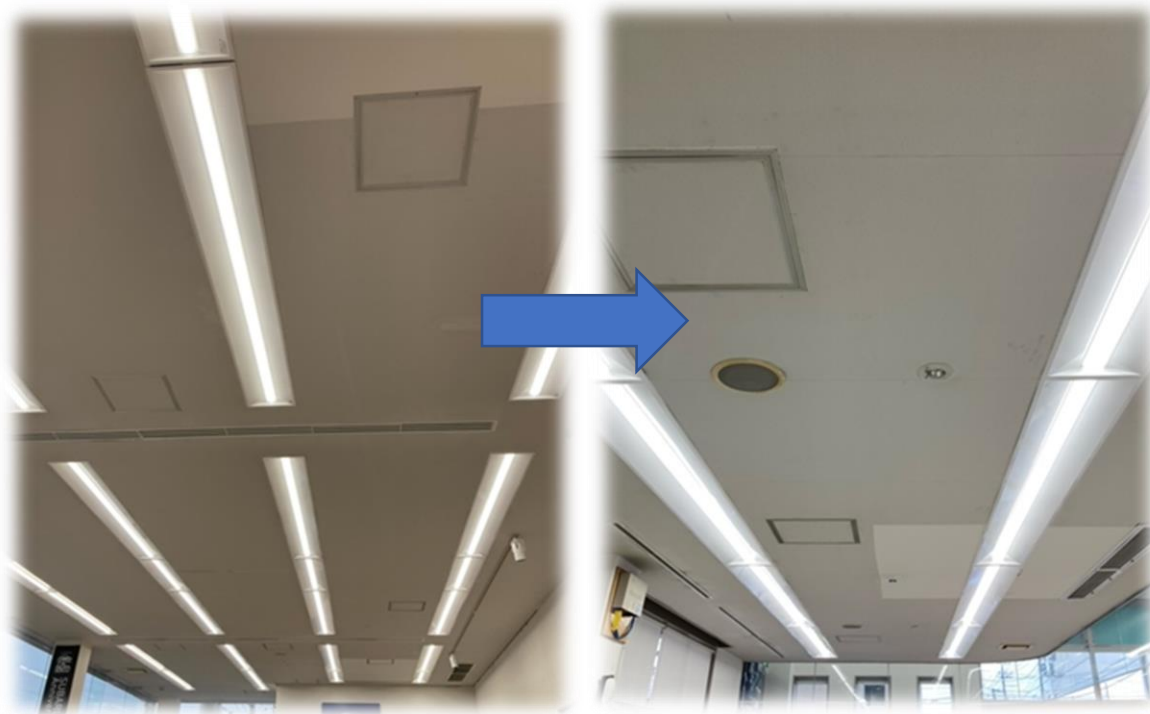
既存の店舗も順次LED照明に交換を行っています
