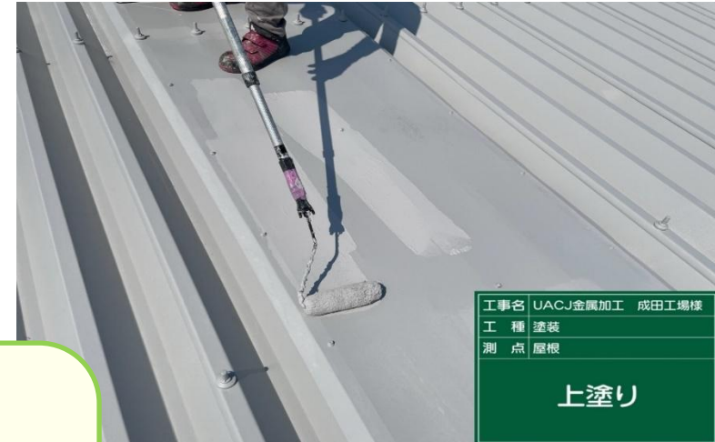
【第二工場屋根塗装工事_中塗り・上塗り】
