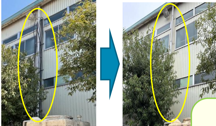
【スプリンクラー撤去（第二工場西側壁面）】
